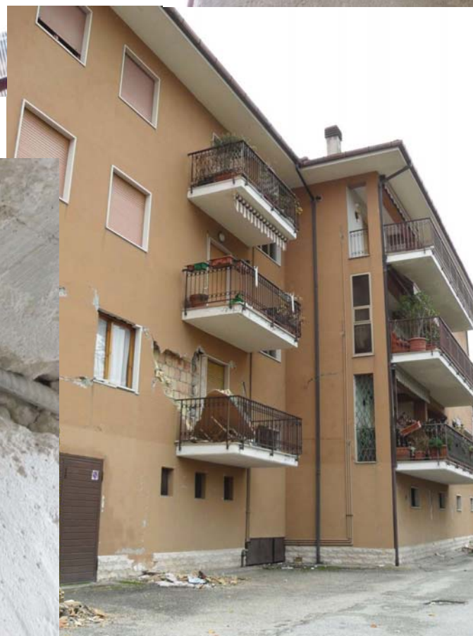
L'Aquila Palazzina Vittorini Struttura: telaio in C.A.
