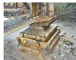
Gli appoggi prima dell'intervento
