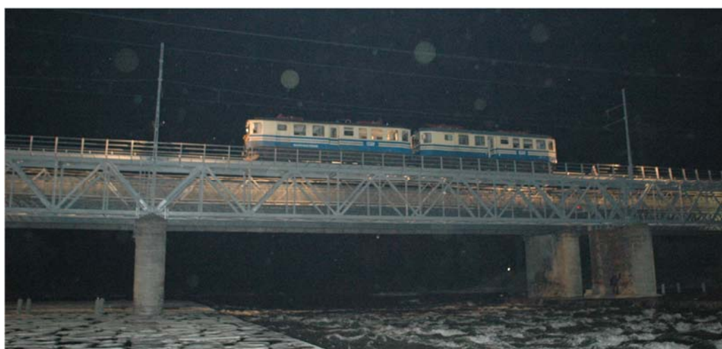
La prova di carico ad intervento eseguito
