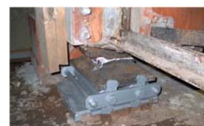
I nuovi appoggi in sede
