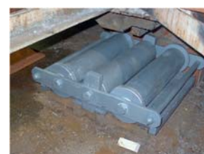
I nuovi appoggi in officina
