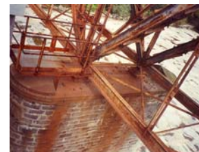
Gli appoggi prima dell'intervento
