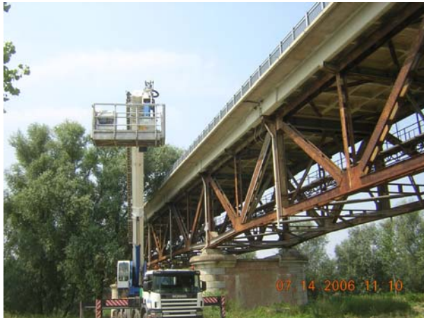
Ponte sul Po a Piacenza: vista di una delle campate centrali
