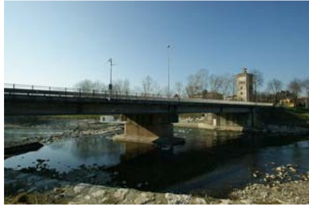
Ponte sul Serio a Montodine
