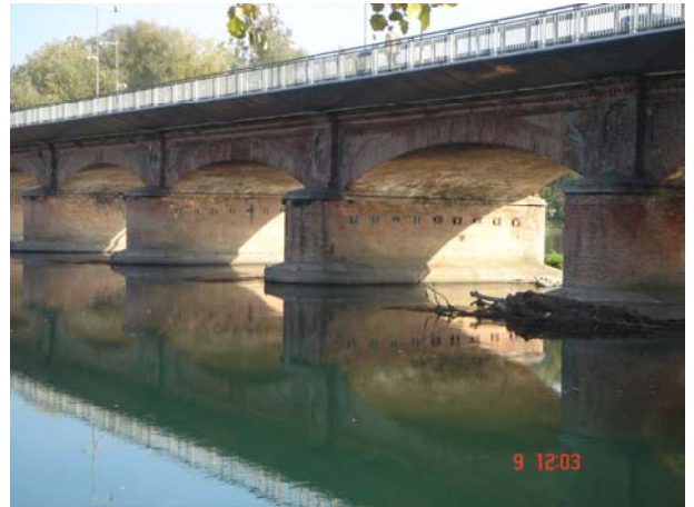
Ponte sul Po a Piacenza: vista dei viadotti di accesso
