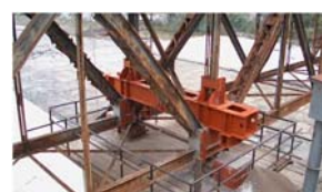
La struttura provvisoria per il sollevamento con i martinetti idraulici
