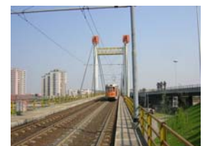
Il ponte tramviario di via Palizzi
