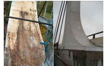
Le antenne del ponte strallato Kennedy, prima e dopo l'intervento.
