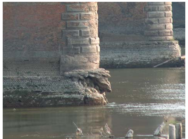
Ponte sul Po a Ostiglia: particolare delle pile in alveo
