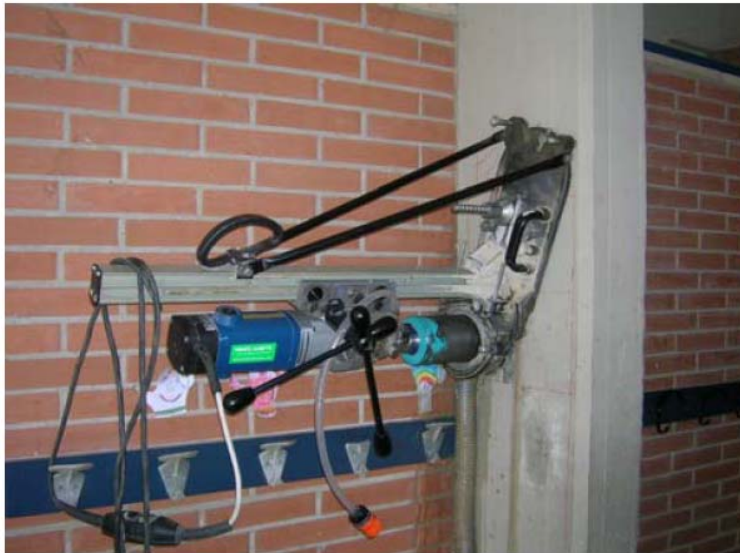
Carotaggio su pilastro
