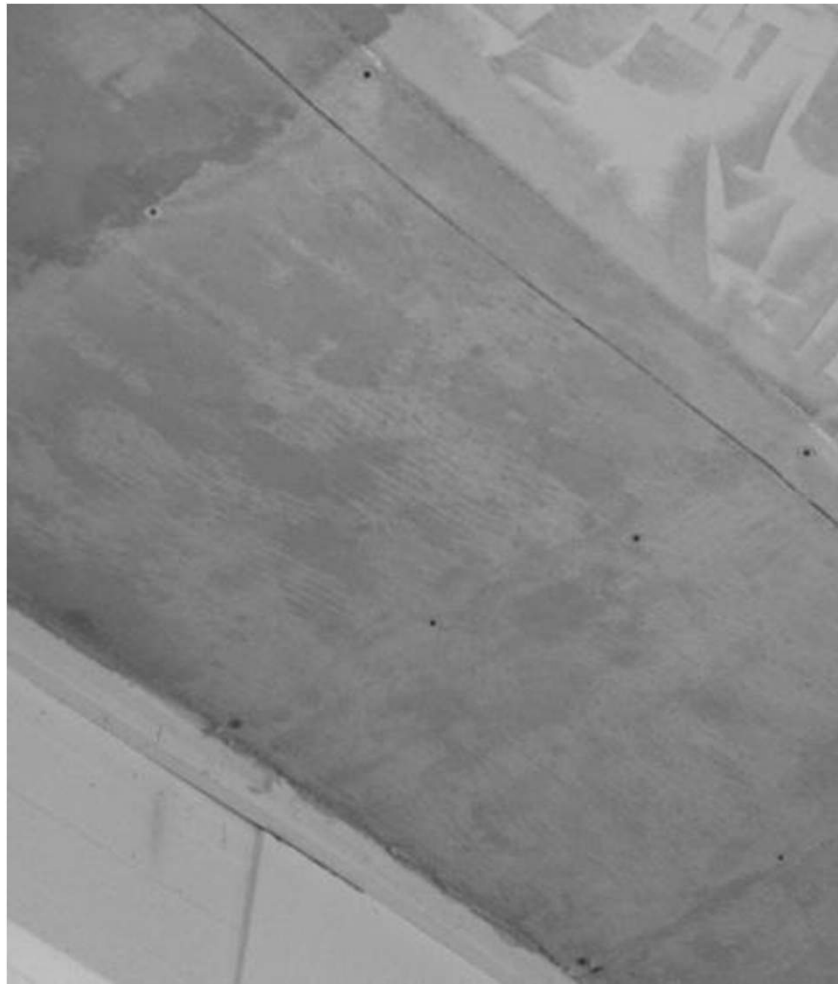
Applicazione all'intradosso del solaio
