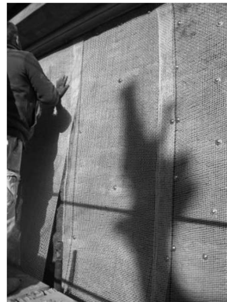
Posa Aegis e fissaggio
