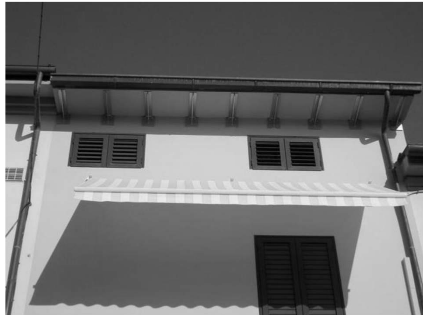
Intervento finale con inserimento di mensole in acciaio
