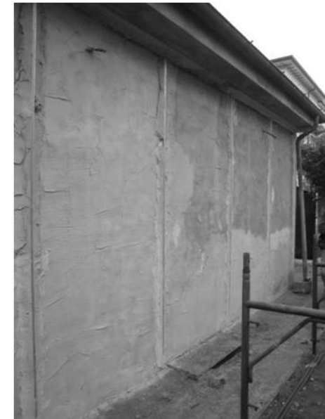
Intonaco pronto per la finitura
