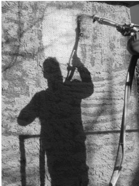
Intonacatura a spruzzo
