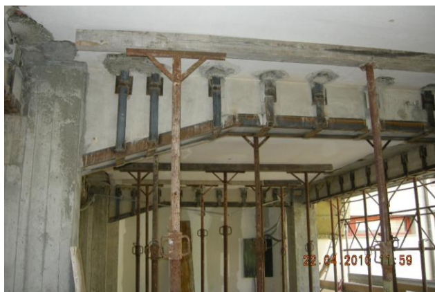
Particolare armatura pilastro e consolidamento delle travi
