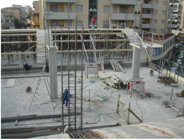
Vista delle centine delle volte di copertura e del solaio
