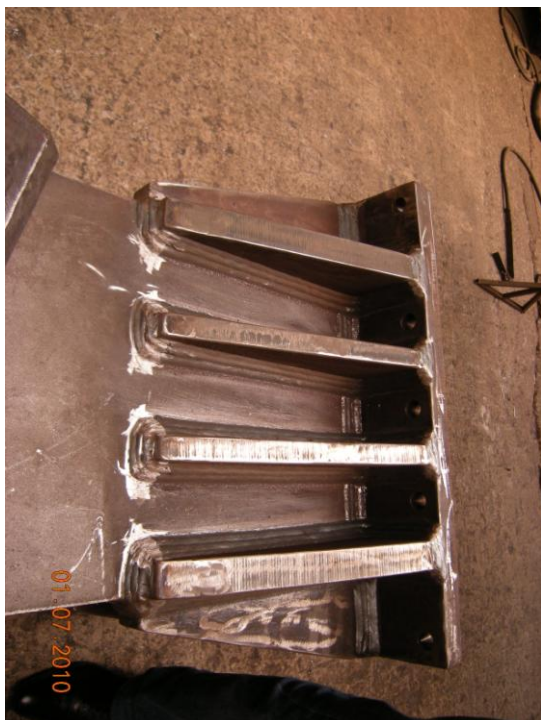
Verifica in officina delle saldature del pilastro
