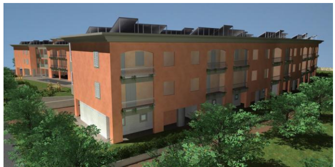
Prospetto nord del complesso edilizio
