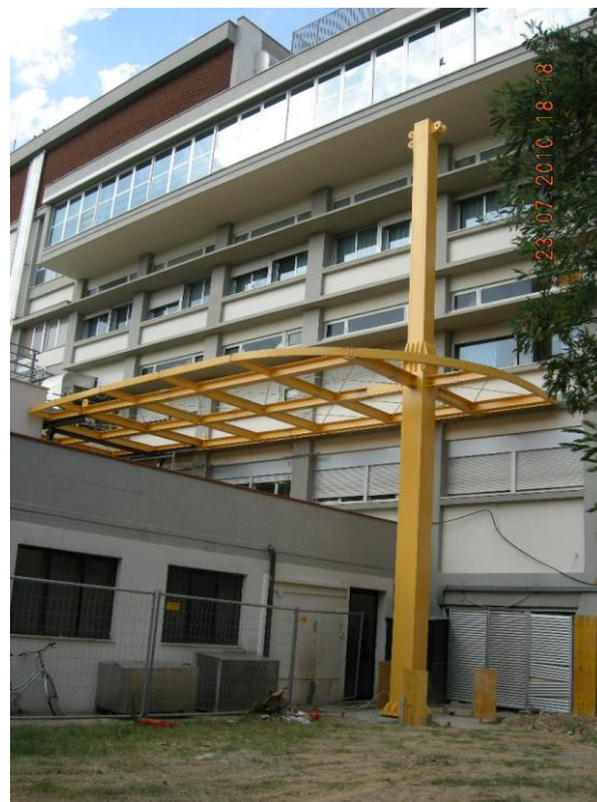
Vista della struttura in acciaio montata
