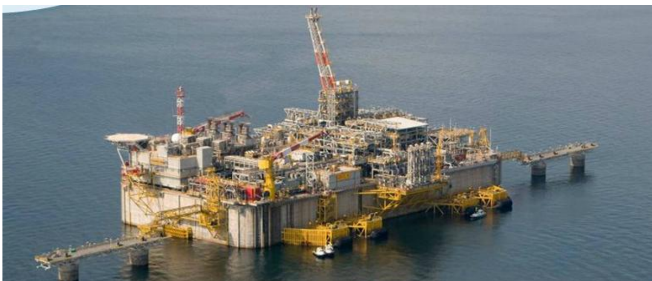
Impianto di rigassificazione dell'Alto Adriatico: lavori ultimati
