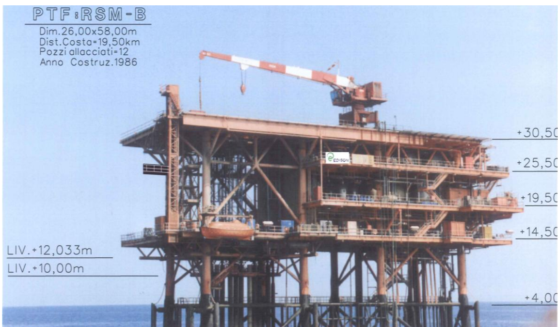
Piattaforma fissa Rospo Mare B
