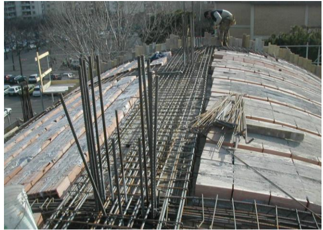
Vista delle centine delle volte di copertura e del solaio
