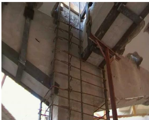
Particolare armatura pilastro e consolidamento delle travi
