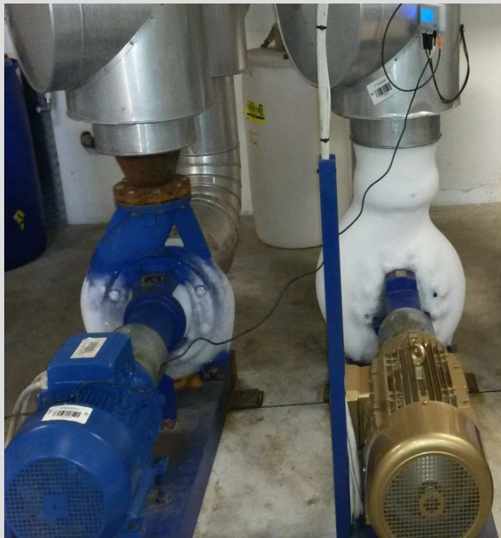
Tipico Installazione di n.1 SuPremE + PumpDrive
