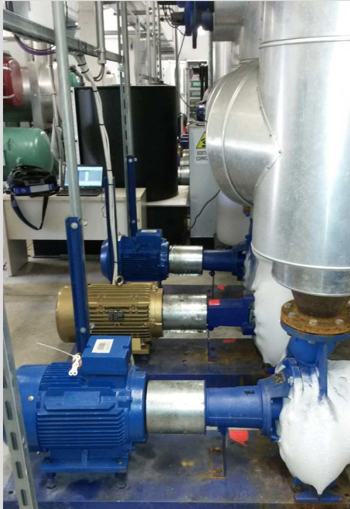
Tipico Installazione di n.1 SuPremE + PumpDrive
